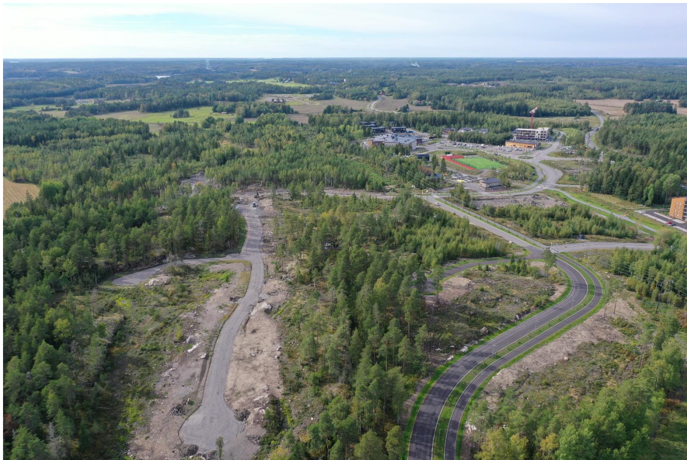
Drone-kuva Aurinkotuulen alueen itäreunalta elokuulta 2024. Kuvassa näkyvät kesällä 2024 valmiiksi rakennetut Luode- ja Taivaankansi-kadut, sekä vielä keskeneräiset Pyrstötähti- ja Tähdento-kadut. (Alkuperäinen kuva: Veijo Lindgren)
